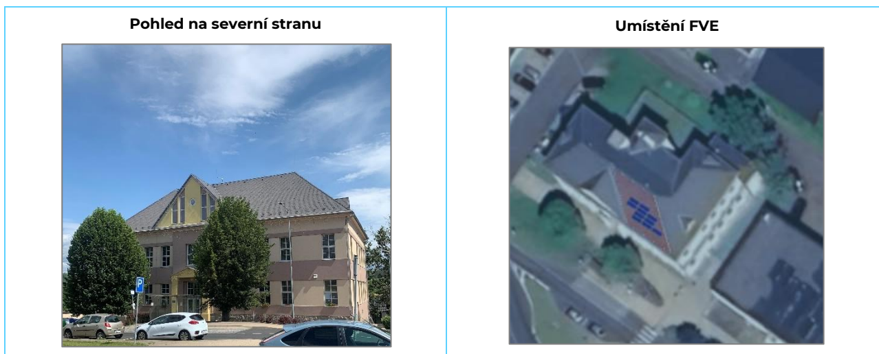
Obrázek 7 Fotodokumentace – budova ICVA, způsob umístění FVE
